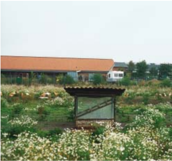
Figur 2. Hønseshus fremstillet af genbrugsmaterialer, gamle vinduer, lægter og eternitplade.
